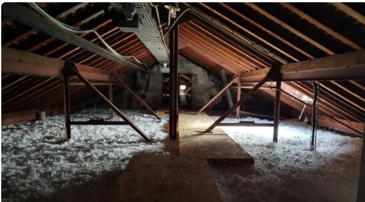
Flocage des combles de la Pitié Salpêtrière - AP-HP
